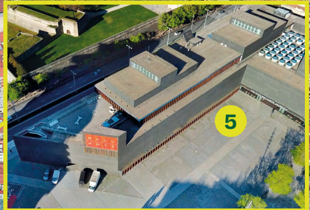
BALUARTE Puerta 5. Sala de la Muralla
